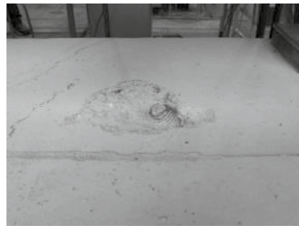
(d) failure mode of specimen ②
